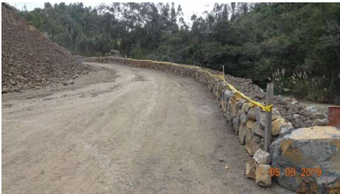
Foto 8-2: Barrera de protección del margen derecho del río
