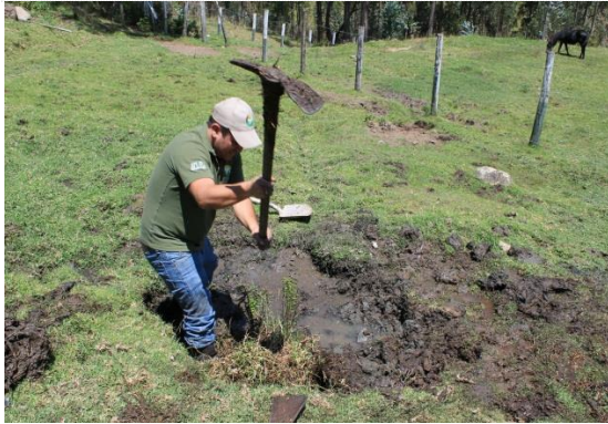
Foto 13: Construcción de posas en el sector de Yanaturo vivero de ETAPA E.P
