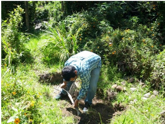
Foto 15: Creación de posa en el sector de Puertas del sol
