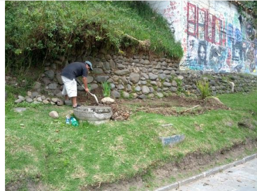
Foto 14: Construcción de posa sector el barranco.
