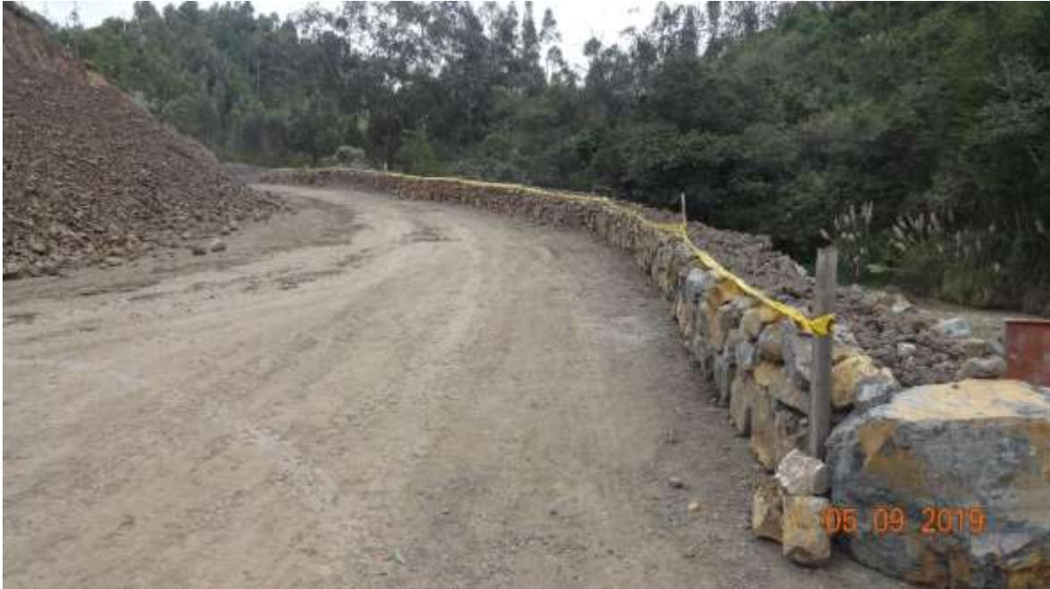
**Foto 8-2:** Barrera de protección del margen derecho del río
